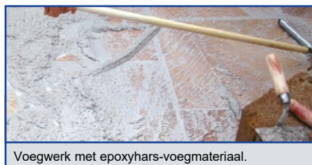
Voegwerk met epoxyhars-voegmateriaal.
