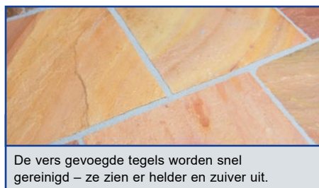
Voegwerk met epoxyhars-voegmateriaal.
